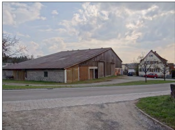
leer stehendes Scheunen- und Stallgebäude
