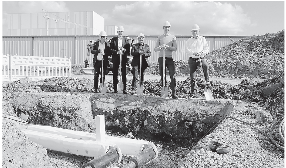
Zum Spatenstich in Crailsheim trafen sich (von links): Thomas Teuchert (Geschäftsführer Bürger), Jürgen Breit (technischer Geschäftsführer Stadtwerke Crailsheim), Uwe Macharznski (kaufmännischer Geschäftsführer Stadtwerke Crailsheim), Martin Bihlmaier (Geschäftsführer Bürger) und Michael Kugel (Geschäftsführer Bürger). Foto: Stadtwerke Crailsheim
