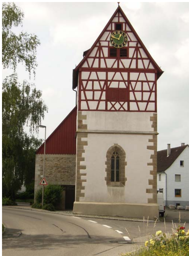
Ev. Mathäuskirche in der Ortsmitte
