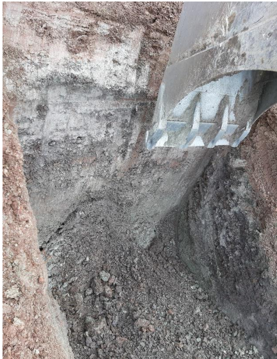
Foto Nr. 2: Eröffnung mit Bagger
