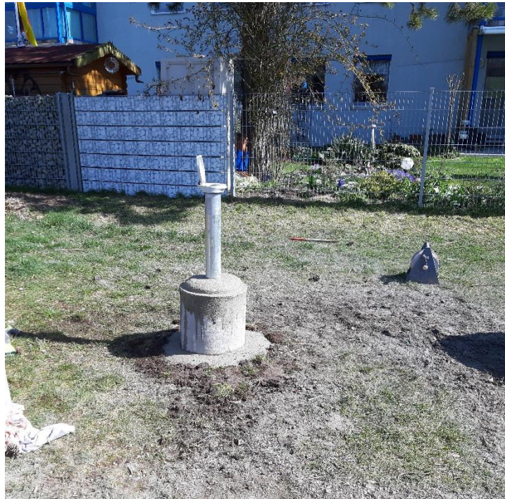
Foto Nr. 10: Überflurausbau GWM
