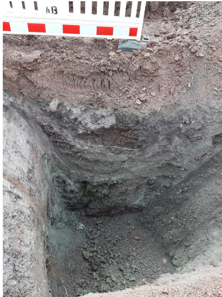
Foto Nr. 3: Aushub verstärztes Material bis 3,5 m u. GOK
