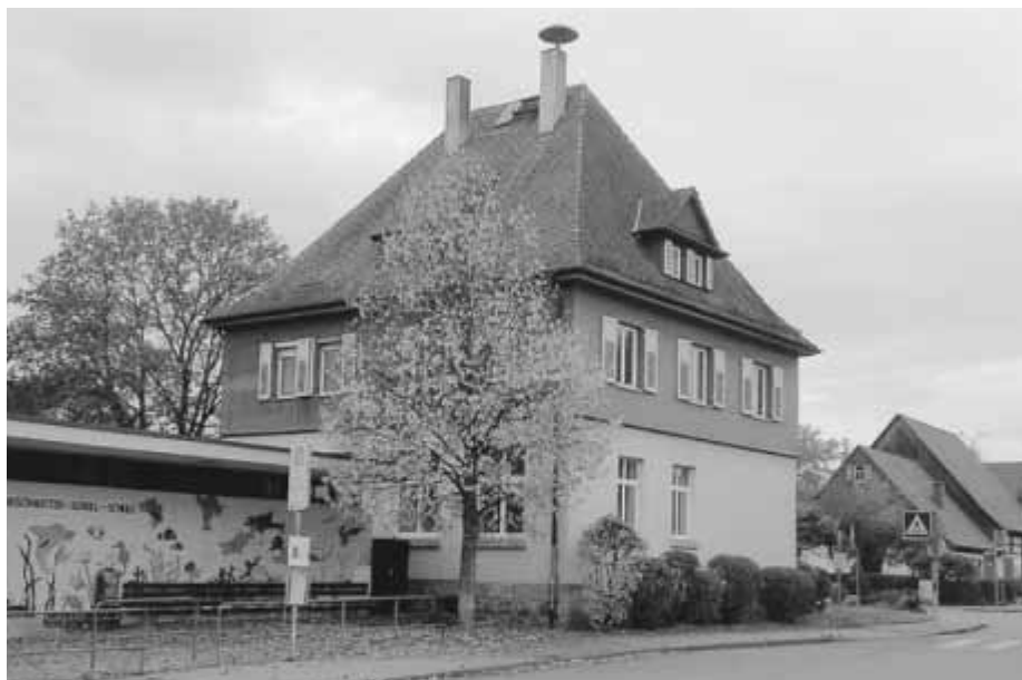
Die Gebäudehülle des ehemaligen Ingersheimer Kindergartens wird saniert.
