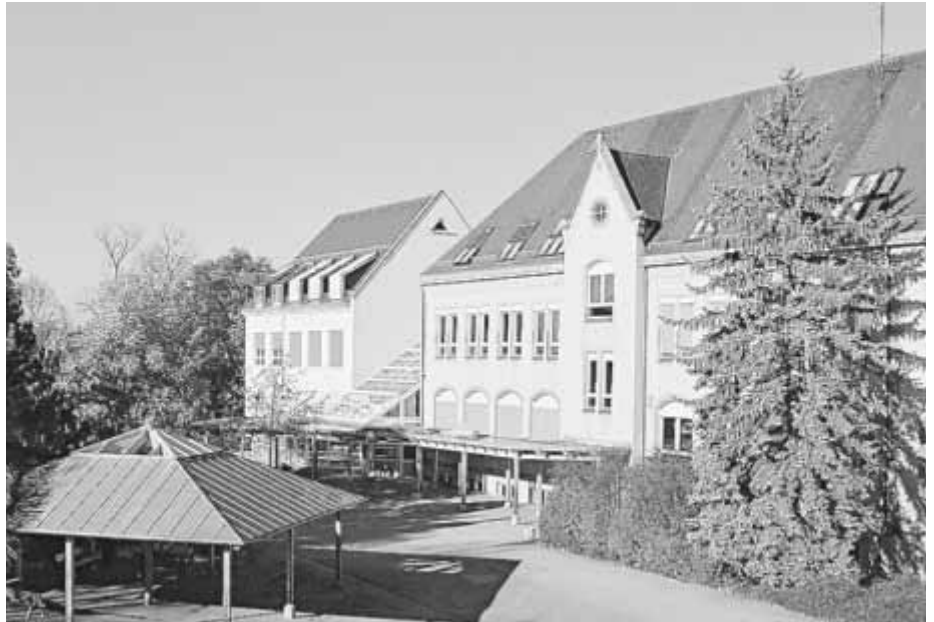
Der lang gehegte Wunsch einer Sanierung der Leonhard-Sachs-Schule wurde durch den Beschluss des Gemeinderats erfüllt. Foto: LSS
