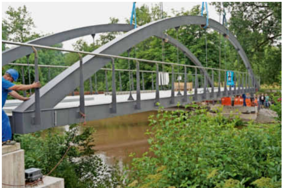
Auch bei einer tonnenschweren Brücke ist Millimeterarbeit gefragt.
