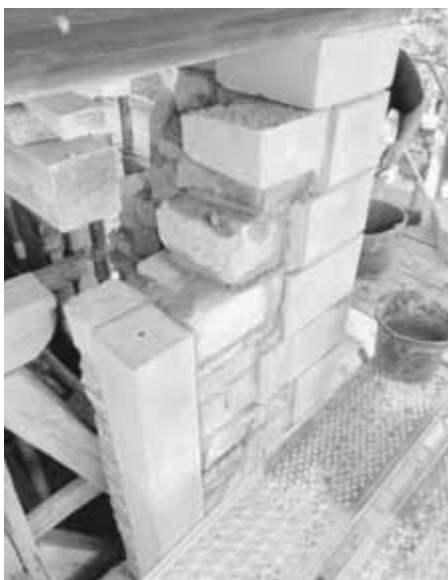
Umfangreiche Steinmetzarbeiten waren insbesondere im Bereich des Turms notwendig.
