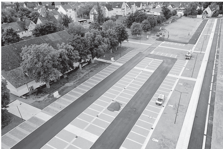
Derzeit laufen noch die Arbeiten für die Parkplätze auf dem Volksfestplatz. Nach dem Volksfest werden dann die weiteren Maßnahmen folgen.
