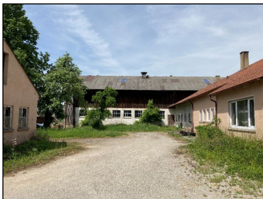
Abbildung 3: Ehemaliges Hofgelände (Stand 19.05.2022)
