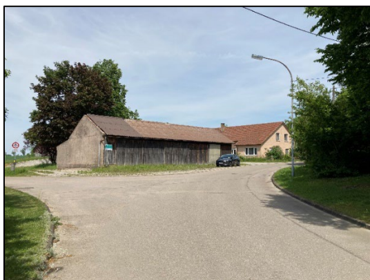
Abbildung 5: Ehemaliges Hofgelände (Stand 19.05.2022)
