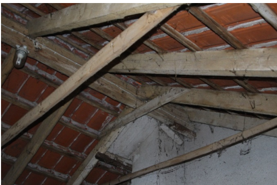
Abb. 18: Der Giebelbereich des Schweinestalls zwischen Wohngebäude und Scheune bietet hinter den Balken bedingt Quartiermöglichkeiten für Fledermäuse
