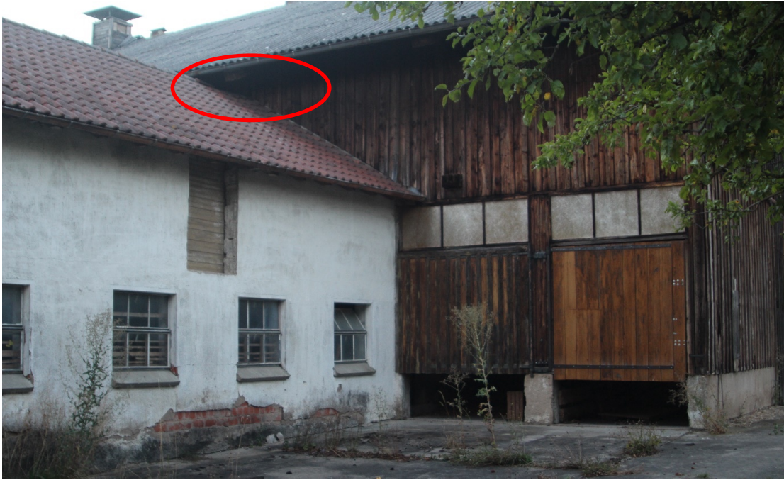
Abb. 21: Ostfront des Schweinestalles, rot markiert ist der Bereich der Schwärmaktivität einer Zwergfledermaus
