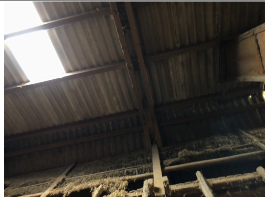
Abb. 5: Dachstuhl von großer Scheune
