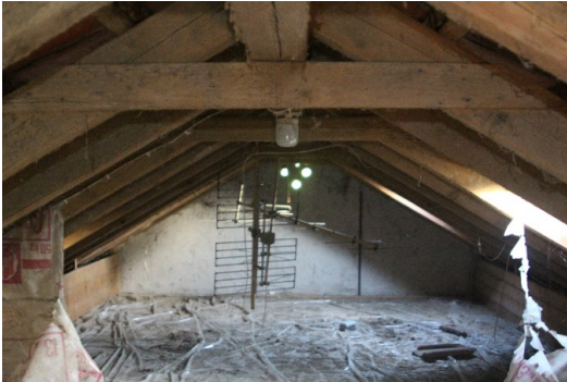
Abb. 14: Dachboden des Wohnhauses im Plangebiet
