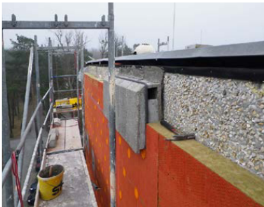
Abb. 28: Großraumeinbaustein in der Einbauphase sowie sechs nebeneinander angebrachte Großraumeinbausteine, Frontalansicht und Ansicht von unten.
