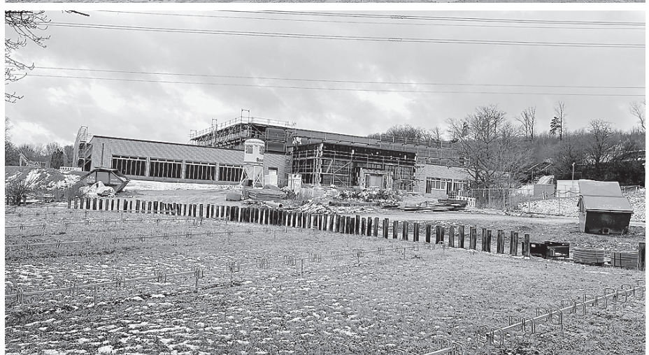
Die seit Jahresanfang vorherrschenden winterlichen Wetterbedingungen haben auch Einfluss auf den Baufortschritt des neuen Hallenbads sowie das Freibad. Fotos: Stadtwerke
