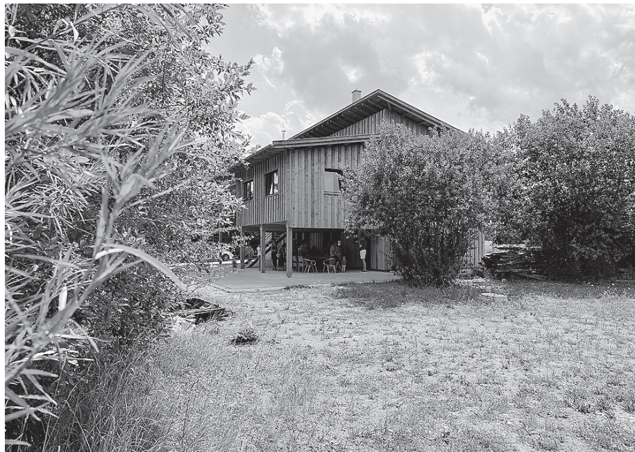
Das Haus der Begegnung liegt idyllisch gegenüber dem Wertstoffhof, wobei im Außenbereich auch noch einiges geplant ist. Fotos: Stadtverwaltung
