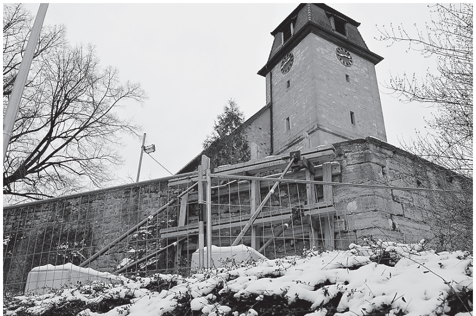
Die marode Mauer wird bereits gestützt und jetzt saniert.
