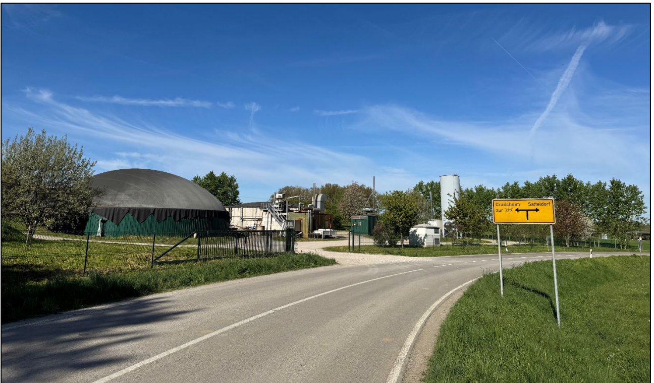
Abbildung 3: Blick von der Kreisstraße 2695 auf die Einfahrt der Anlage
