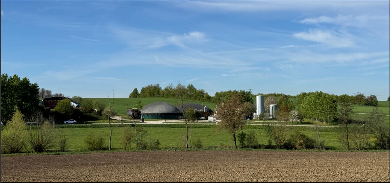
Abbildung 2: Blick aus nördlicher Richtung auf die Anlage
