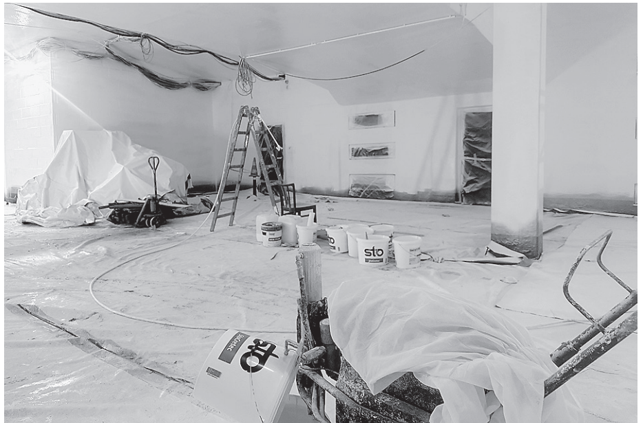
In den unteren Etagen wurde so manches erledigt, hier das frisch gestrichene Zwischendeck. Foto: Stadtverwaltung
